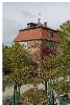
BayEr.V, älterer Wasserturm, DI008303, BSV-
