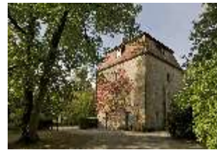
BayEr.V, älterer Wasserturm, DI008286, BSV-
