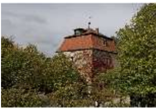
BayEr.V, älterer Wasserturm, DI008302, BSV-
