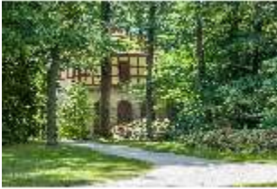
BayEr.V, Jüngerer Wasserturm, DI007503, BSV-
