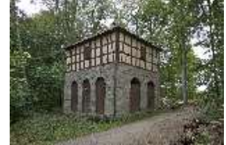
BayEr.V, jüngerer Wasserturm, DI008305, BSV-
