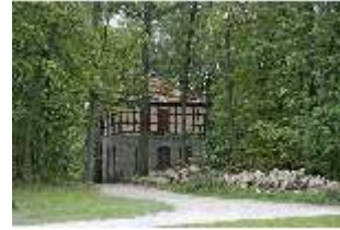
BayEr.V, jüngerer Wasserturm, DI008304, BSV-
