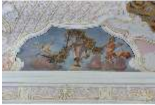
BayEr.II, Fresko, Deckenkehle, Marmorsaal, R. 1, DI019344, BSV
