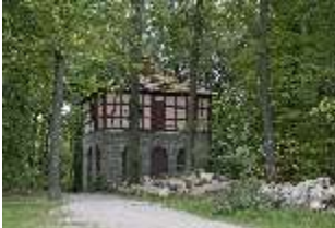
BayEr.V, jüngerer Wasserturm, DI008306, BSV-
